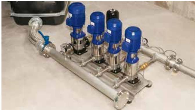
Typischer Vertreter eines Fluidfördersystems: Druckerhöhungsanlage am Versuchsstand zur Wasserspeisung eines unbekanntem Rohrleitungssystems sowie zur Druckaufrechterhaltung in selbigem System
