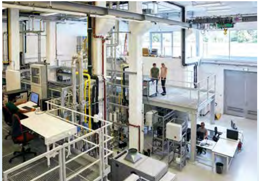
Abbildung 1: Zentrum für Combined Smart Energy Systems (CoSES) der Technischen Universität München
