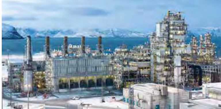
LNG-Verflüssigungsanlage: möglicher Einsatzort von spiralgewickelten Wärmetauschern
