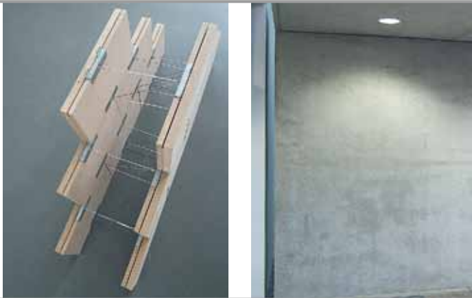
Links: Prinzipmodell der Tragwirkung von Innen- und Außenschale; rechts: Oberflächenqualität und Haptik von Betonoberflächen (Fotos: Lehrstuhl für Baukonstruktion und Baustoffkunde 2011)
