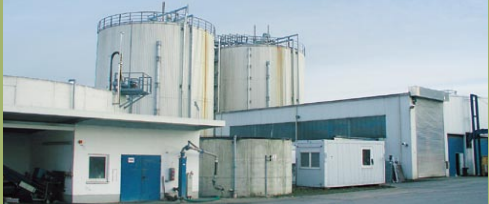
Biogasanlage Fürstenwalde: Mehr Ammoniak senkt Biogasausbeute
